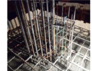
Varmista työmaalle tuotavan betonin laatu ja lämpötila ennen kuoman purkuua. Talvibetonoinnissa valutyö suoritetaan normaaliin tapaan ja betonin vibraus toteutetaan samoin kuin muisakin vastaavissa rakenteissa. Huolehdi, että laadunvarmistus tehdään sovitun mukaiseksi.
